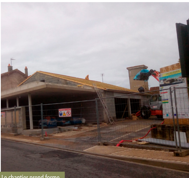
Le chantier prend forme
