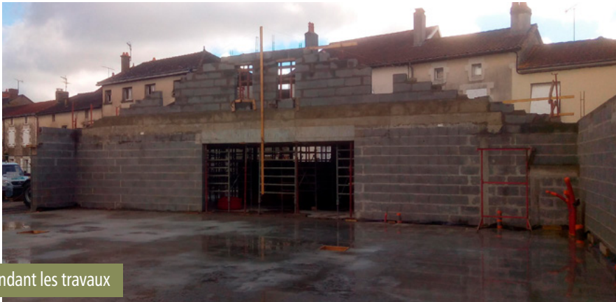
Pendant la déconstruction
